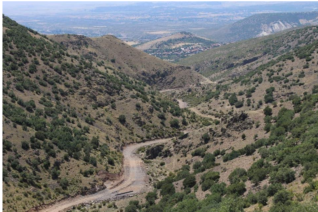
Resim 2 - Güdül Kırkkavak Barajı Sulaması
